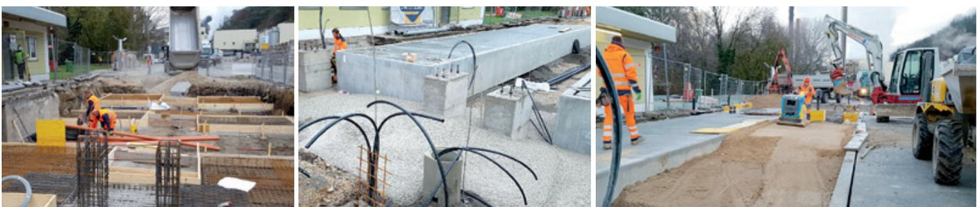
Herstellung – Fundamente für Terminals, Schranken usw. inkl. Leerverrohrungen / Niveaueinrichtung
