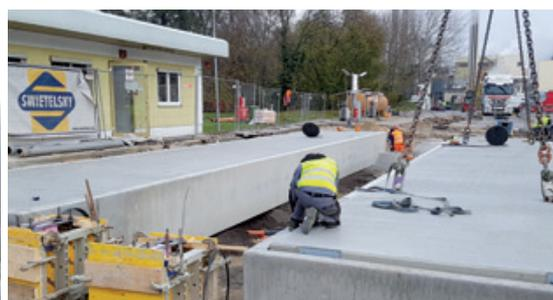
Einheben der beiden Fundamentkeller und der beiden Brückenwaagen-Innenteile
