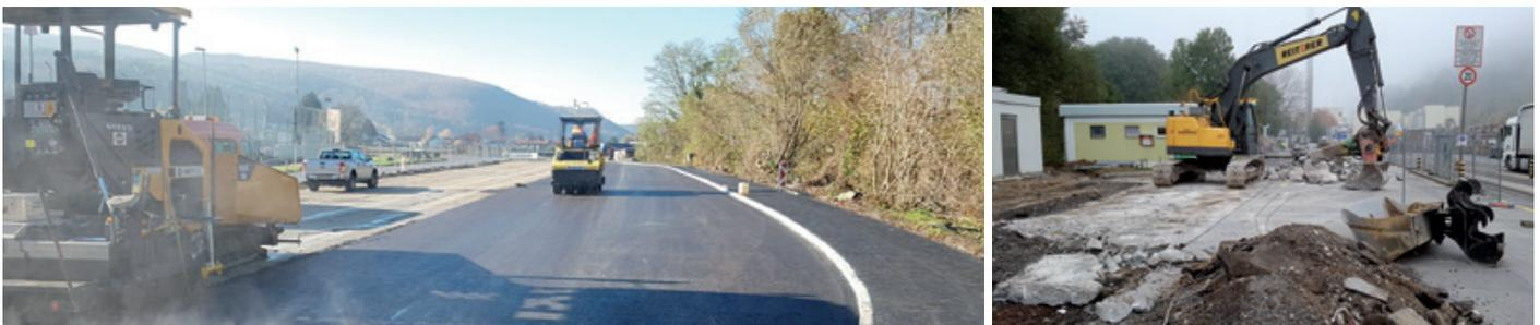
Aufbringen der neuen Asphaltdecke / Abbruch rundum der alten Brückenwaage
