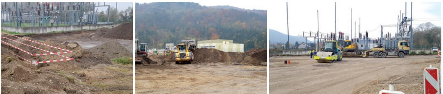
Künetten für Stromanbindung / Untergrundabtrag / Untergrundvorbereitung für Asphalt
