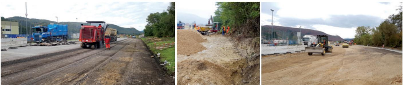
Abfräsen der Asphaltdecke / Böschung abtragen / Untergrundaufbereitung
