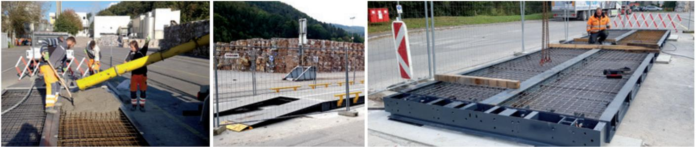
Herstellung der Fundamente für die Leihwaage & Aufbau des Grundkörpers
