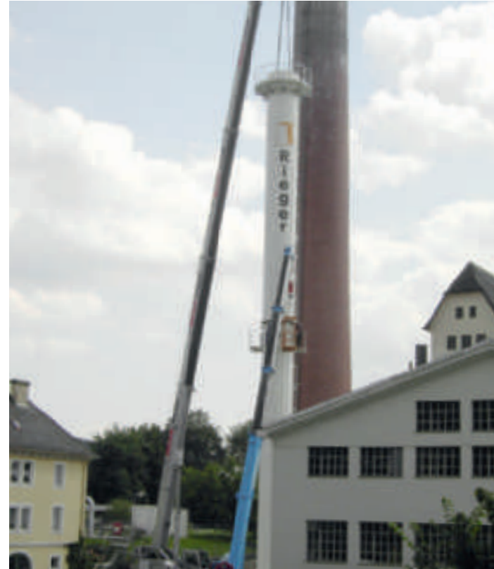
und der neue Kamin beim Aufstellen
