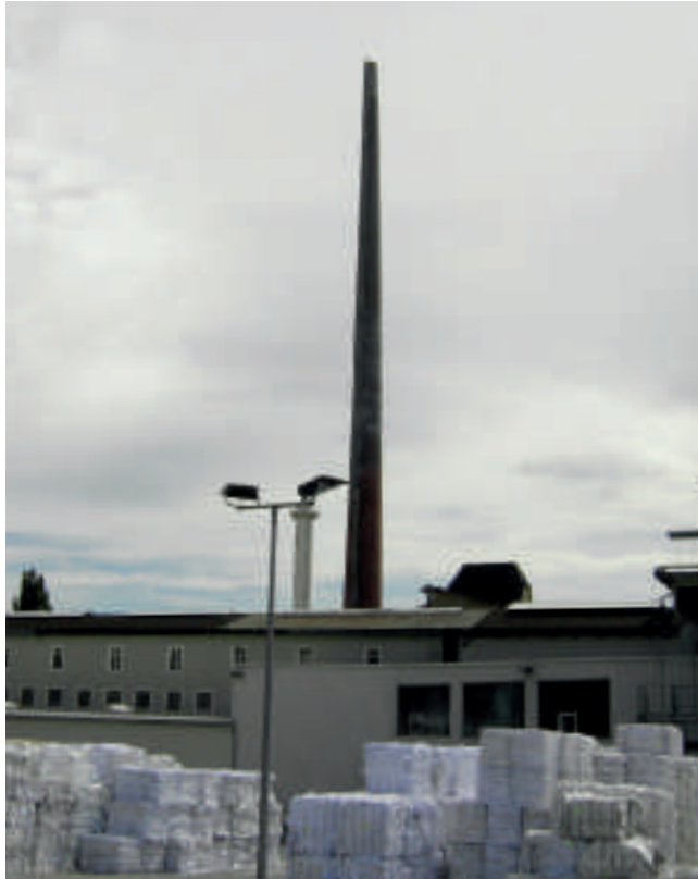
Der alte Kamin kurz vor dem Abbruch
