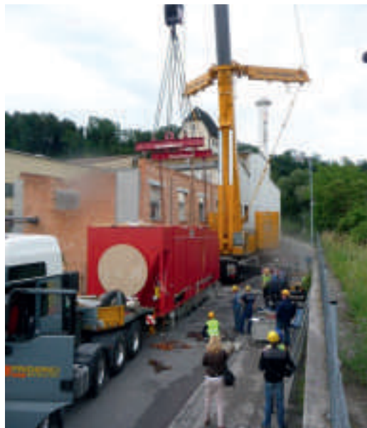
Die Turbine beim Einbringen in das erweiterte Kesselhaus.
