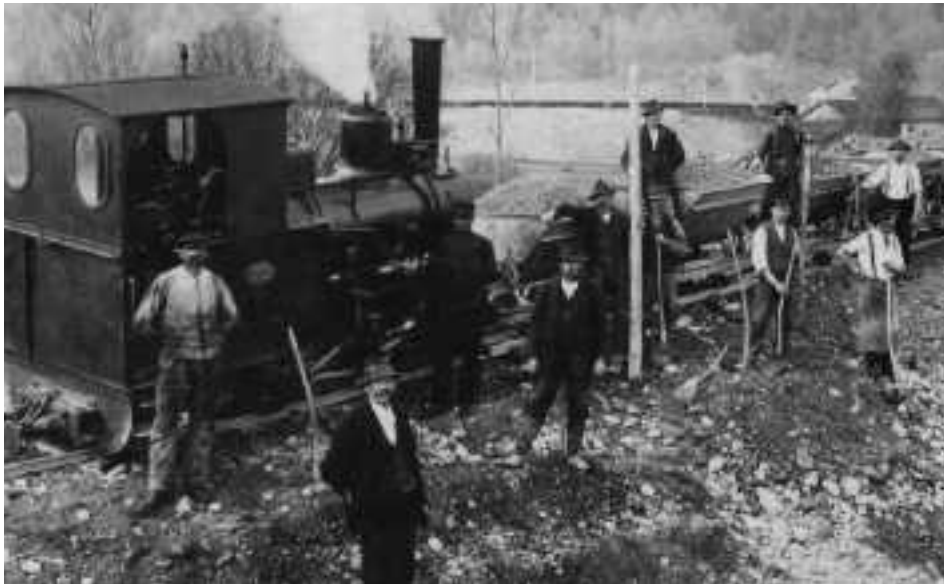
Innerhalb eines knappen Jahres wurde der Rieger-Kanal erstellt. Die Aufnahme zeigt Bauarbeiten unterhalb des heutigen Schwimmbades.
